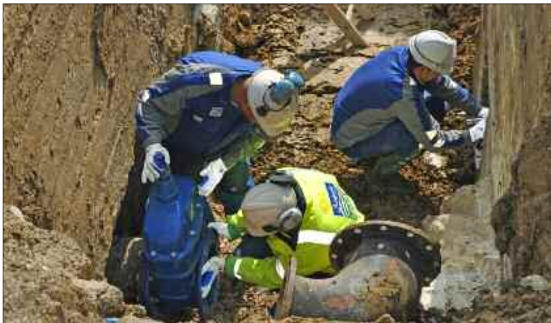
La visite du ministre dans la wilaya de Tébessa lui a permis d'inspecter plusieurs infrastructures hydrauliques, dont le barrage d'Ouldjet Mellègue, dans la commune d'Ouenza, puis de superviser l'inauguration d'une station de pompage d'eau potable. (Photo: D.R)
