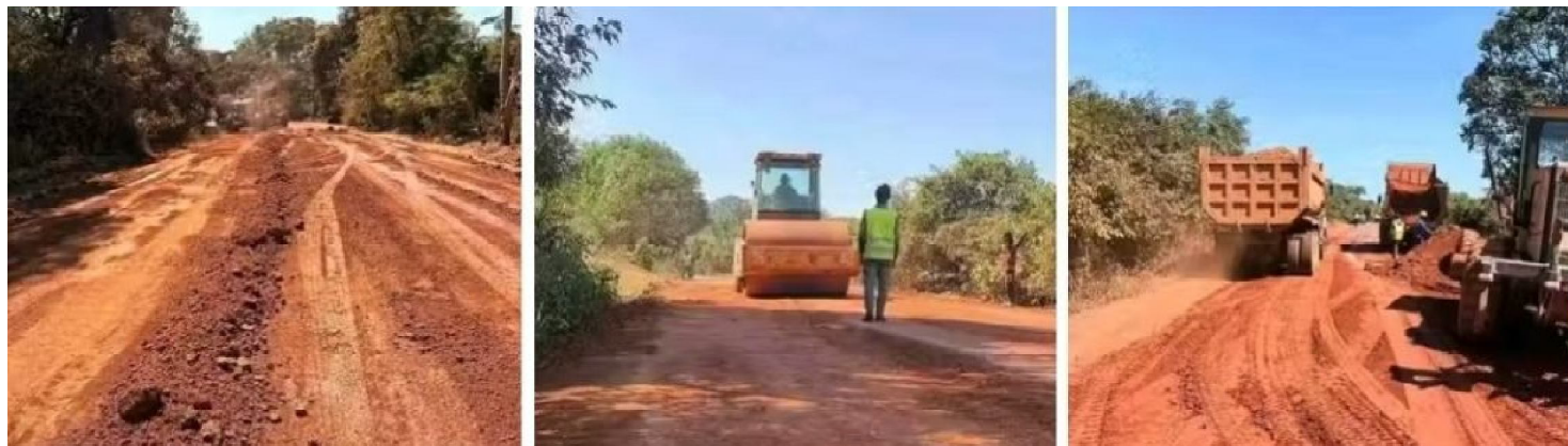
Les travaux incluent le renforcement de la chaussée, la construction de ponts et l'installation de nouveaux dispositifs de drainage pour limiter l'érosion due aux pluies abondantes du Fouta. (© Le Populaire)
